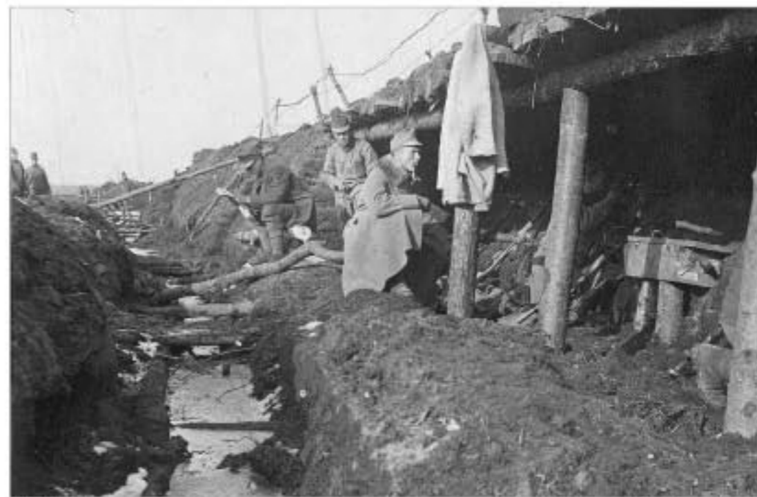
Typická situace po dešti, která nastávala v nezpevněných narychlo vybudovaných zákopech. Zatopené dno zákopu je improvizovaně překryto silnými větvemi.
